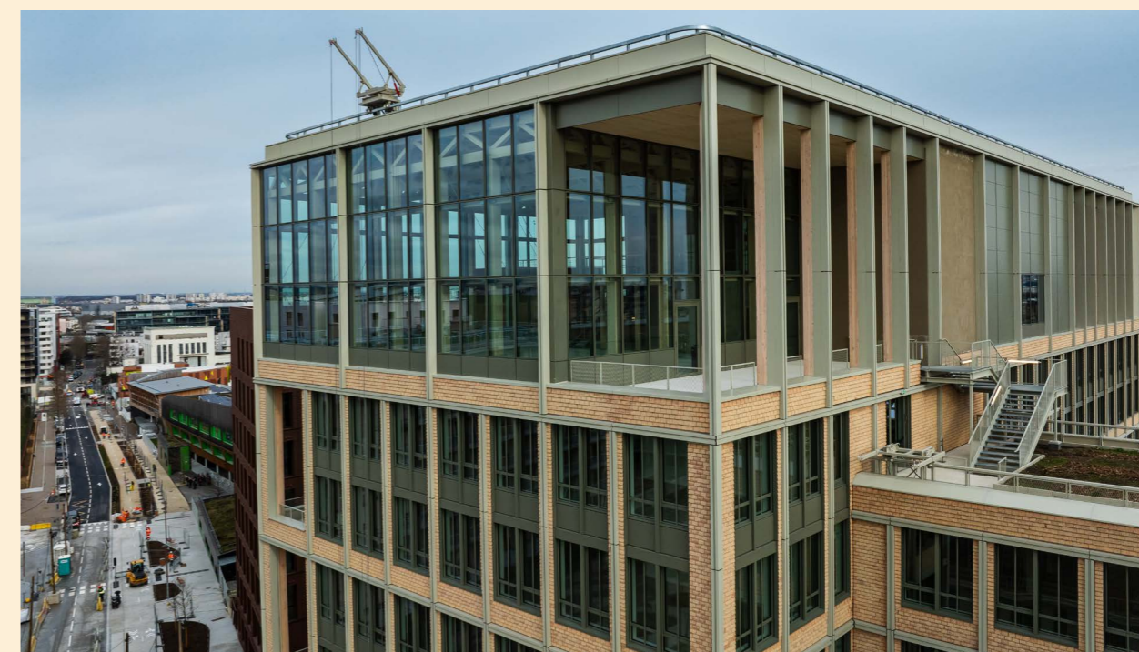
Le bâtiment de bureaux E3 du VOP
