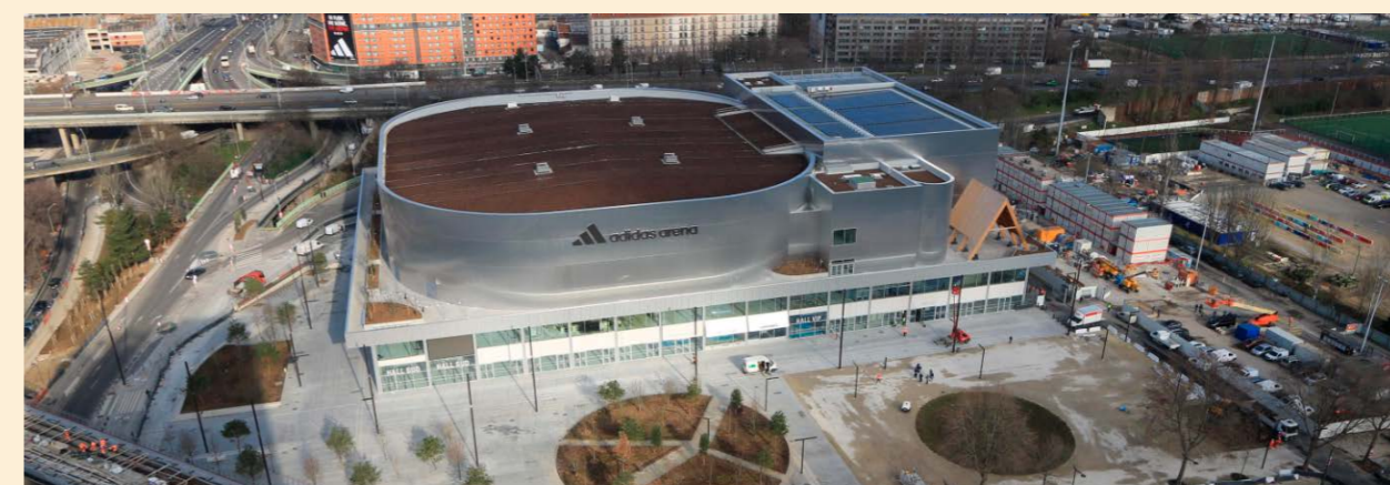
Complexe Phonotech mise en œuvre sur la toiture de la salle principale de l'Arena Porte de la Chapelle
