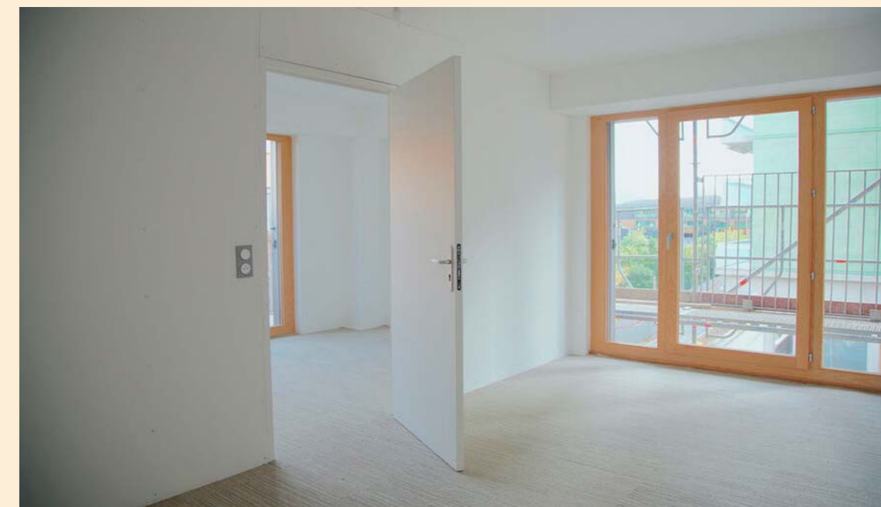
Une des cloisons provisoires installée sur le VOP
