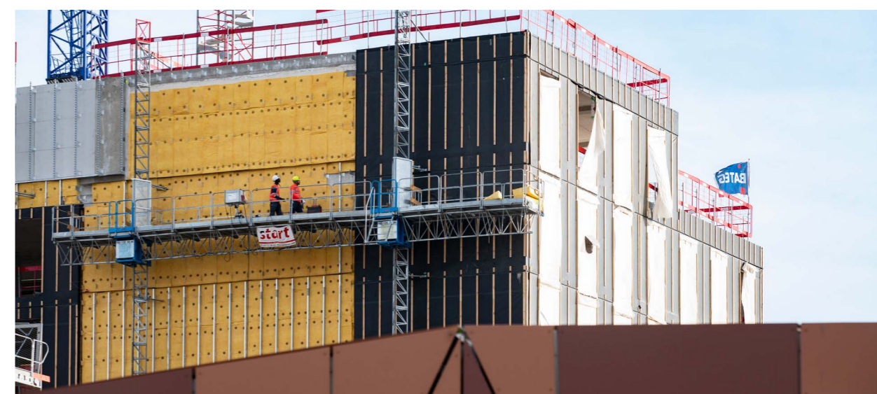
Mise en œuvre de l'isolation des façades du VOP
