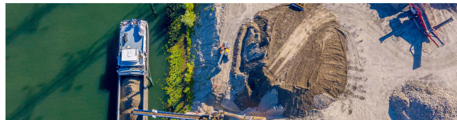
Transport fluvial des déblais
