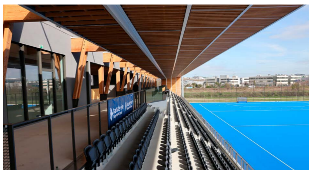
Coursive extérieure donnant sur le terrain principal du stade Yves du Manoir
