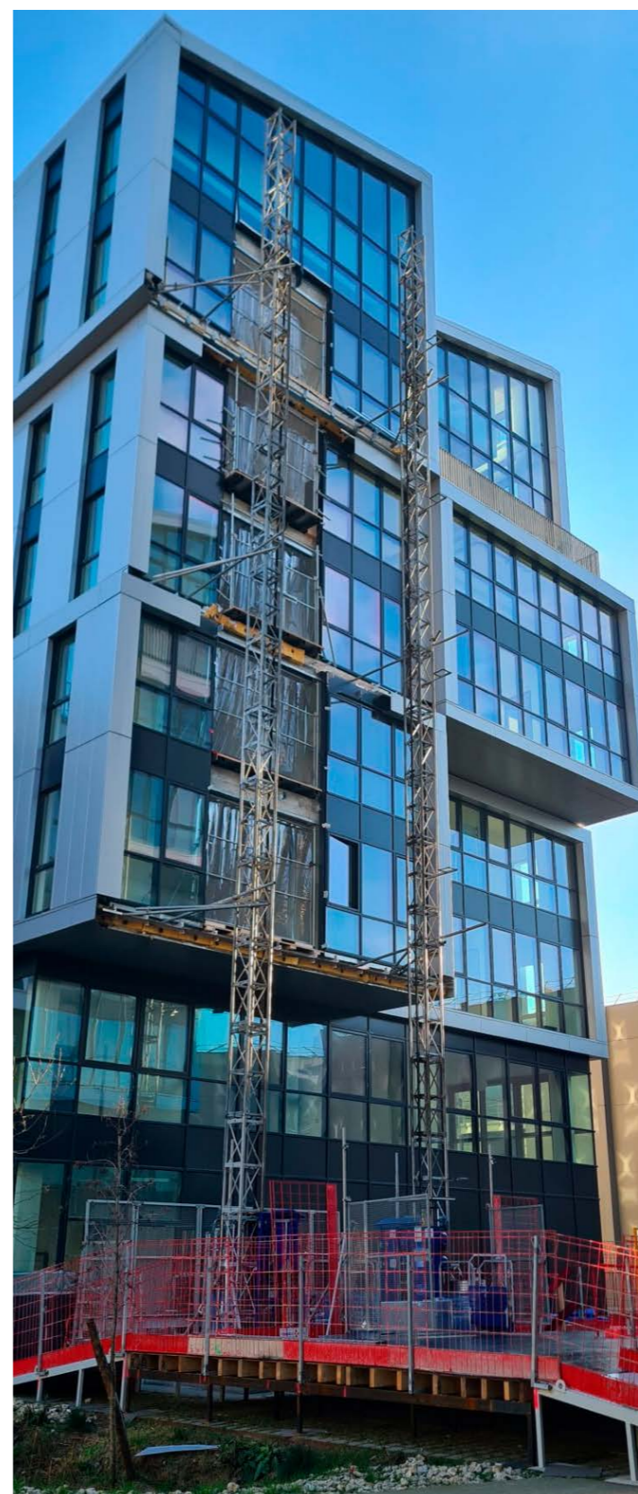
Menuiseries extérieures déposées pour permettre l'évacuation des salles de bains provisoires à l'aide d'un lift
