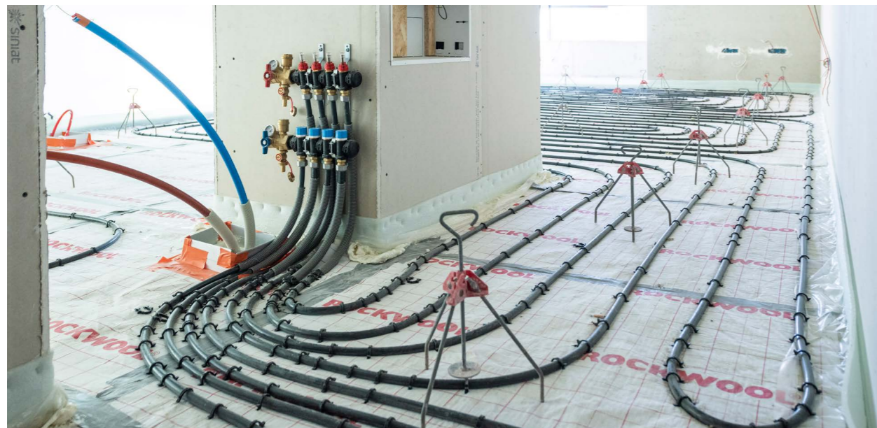
Installation du plancher réversible
