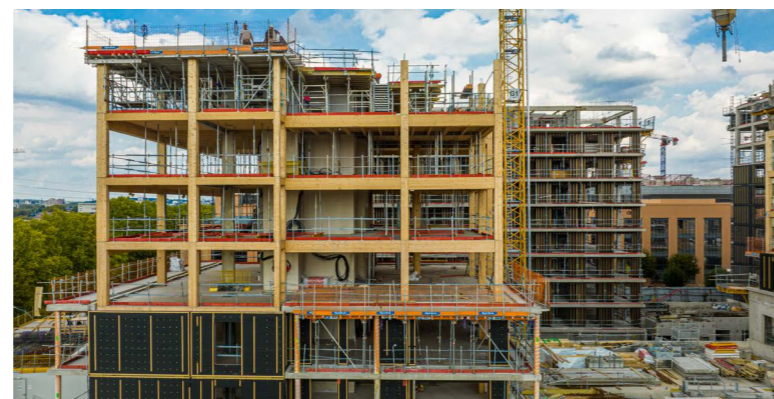
Vue en coupe de la construction d'un bâtiment en structure bois sur le VOP
