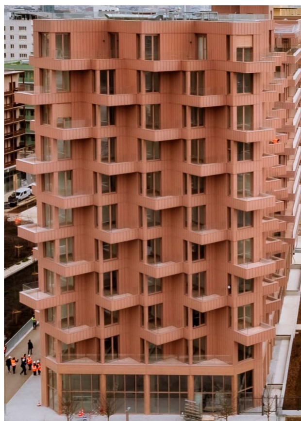
La surface extérieure du bâtiment Ela_1 impacte ses performances
