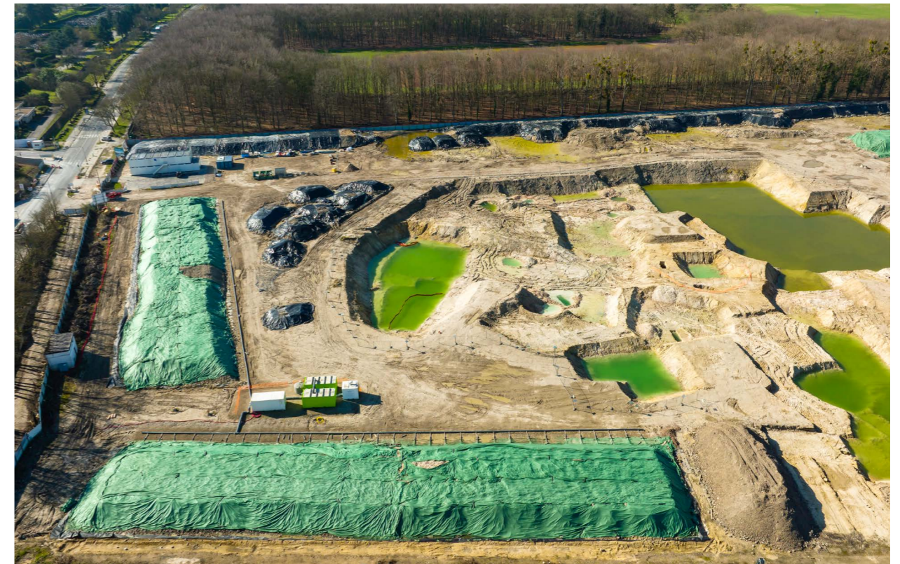
Opérations de dépollution des sols et de la nappe du Terrain des Essences
