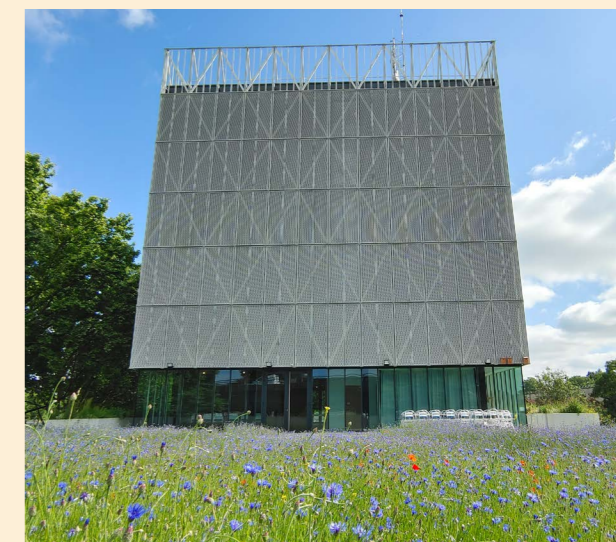
Toiture végétalisée de la remise des engins
