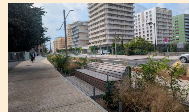
Pavés coquillages (à gauche) et bacs végétalisés (à droite)
