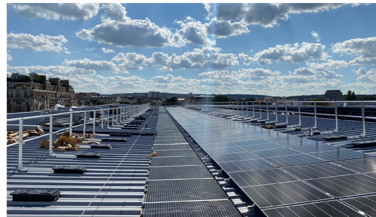
Pose des panneaux photovoltaïques sur la toiture du Court Suzanne Lenglen
