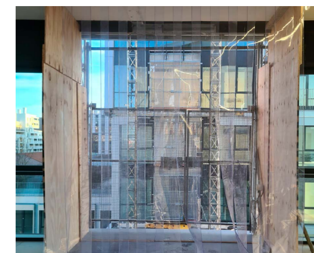
Dépose d'une menuiserie extérieure
