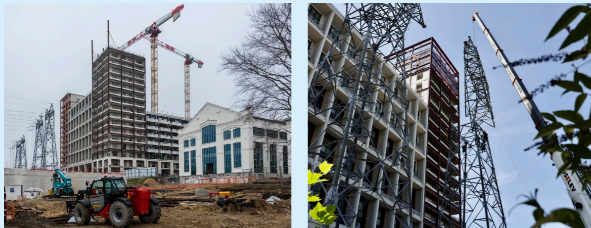
Dépose des 4 pylons, Maître d'Ouvrage RTE
